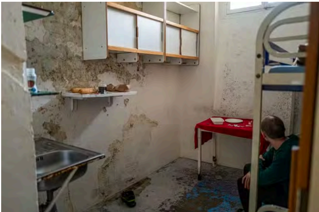
Une cellule de la maison d'arrêt de Nice, en septembre 2024. K.BIZARD/CGLPL
